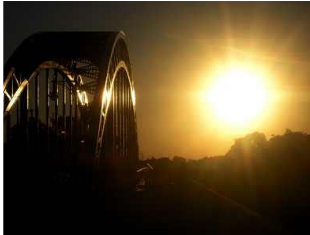
Sternbrücke in Magdeburg
